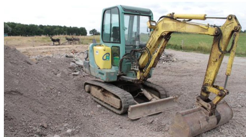
Les travaux d'agrandissement de la ferme.
